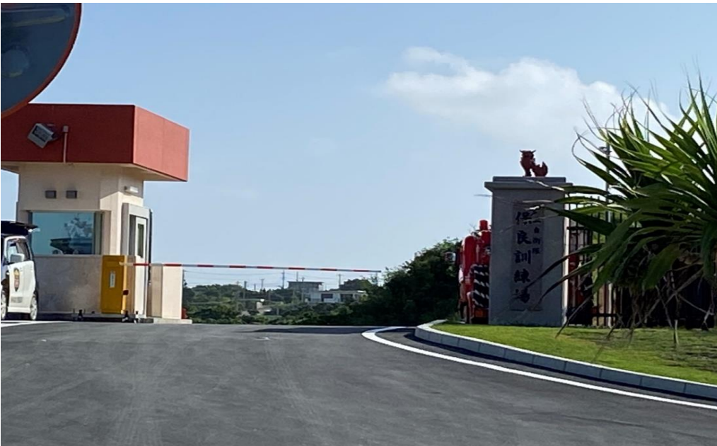
宮古島の保良訓練場。「訓練場」などとされているが「弾薬庫」である。門から集落が見えるように、集落からとても近い場所に「弾薬庫」が建設された。2021年10月撮影。
